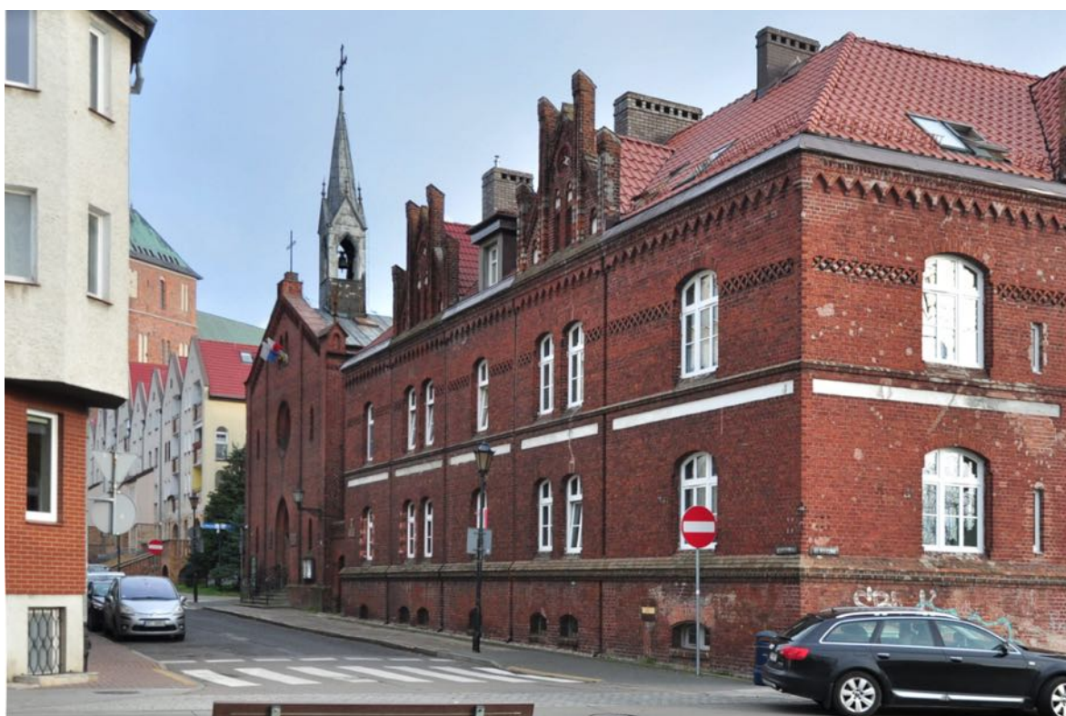
Fot.3 Widok od ulicy Rzecznej, oryginalny neogotyckie szczyt. Prostokątne lukarny po bokach są wynikiem powojennej dewaloryzującej przebudowy. Fot. R. Walkiewicz 2019 r.
